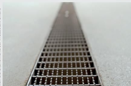
Die Entwässerung in der Parkgarage des Ullrhauses. Der gelochte Anschlussflansch für den Kunstharzbodenbelag sorgt für eine feste Verkrallung mit dem Boden – so bilden die Parkdeckrinne Securin und der Bodenbelag eine absolut dichte Einheit.
