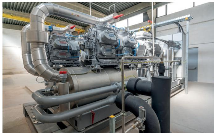
Die neue Großwärmepumpe in Korneuburg (Wärmeleistung 2 MW) nutzt das Wasser der Donau im Sommer und speist die Umweltenergie in das bestehende Fernwärmenetz ein.
